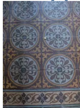
Fliesen im Eingang
