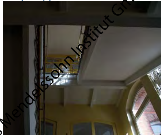
Haupttreppenhaus vor Umbau
